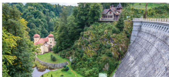
Zapora wodna w Leśnie na rzece Kwisie na Dolnym Śląsku
