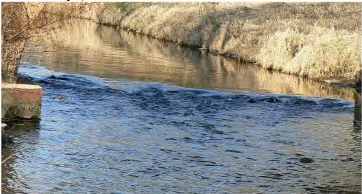
Foto. 71. Obiekt nr 28 - próg w świetle mostu
