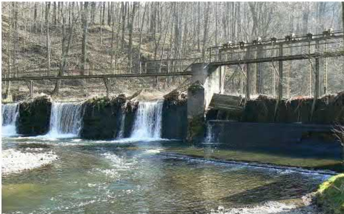
Foto. 88. Obiekt nr 34 widok od strony wody dolnej
