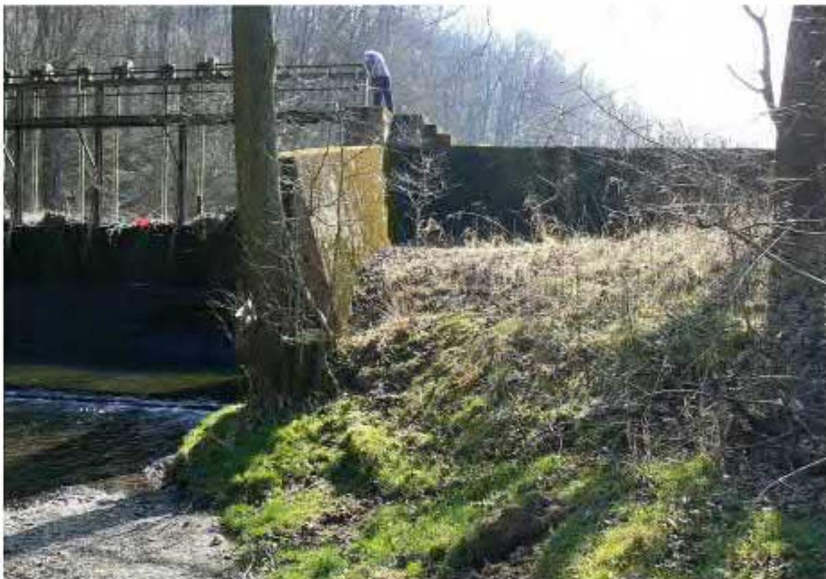
Foto. 91. Obiekt nr 34 - przyczółek prawy od strony jazu ruchomego
