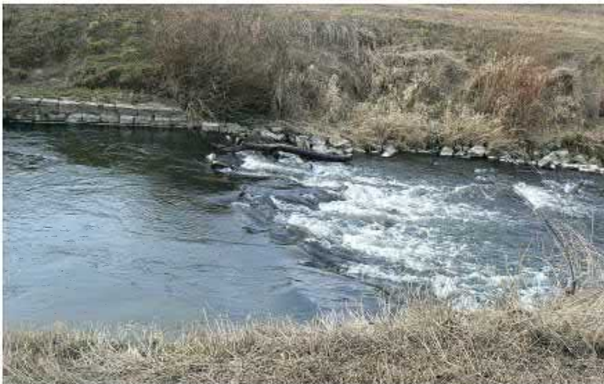
Foto. 30. Próg Legnica - Nowodworska - widok na stanowisko dolne progu
