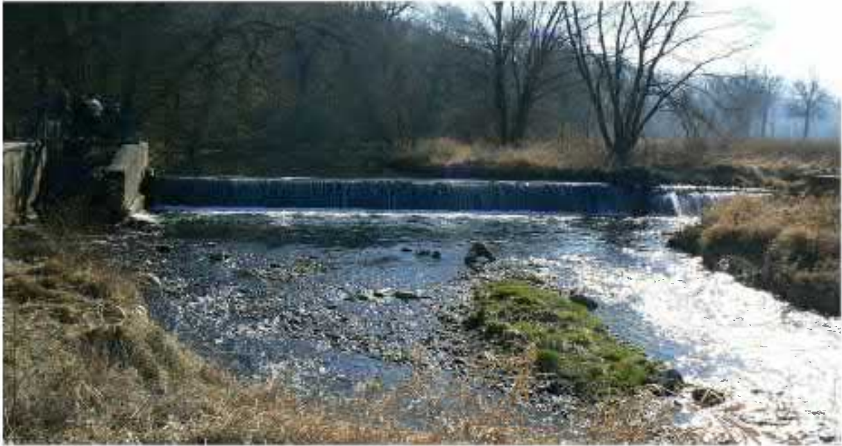
Foto. 81. Obiekt nr 32 - jaz Złotoryja. Widok od strony stanowiska dolnego stopnia.
