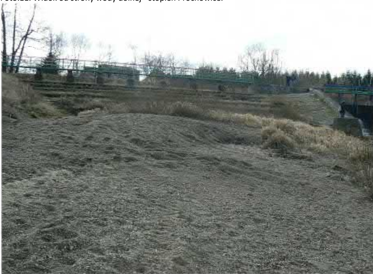
Foto.11. Widok od strony wody dolnej jaz Prochowice - przelew powodziowy
