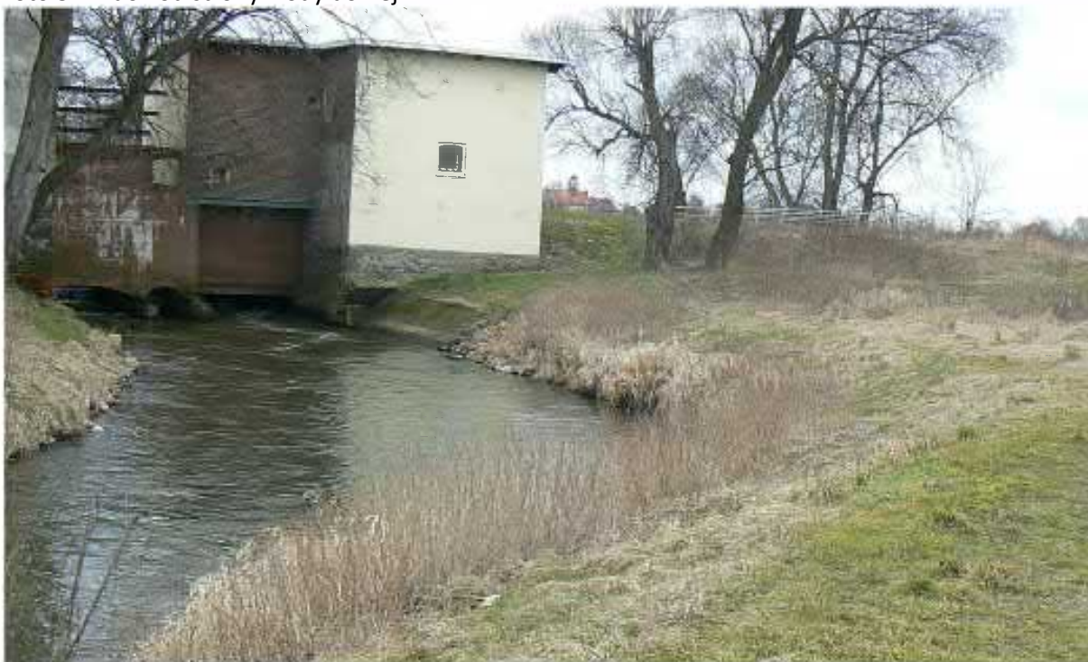
Foto 4. Kanał wylotowy z budynkiem elektrowni MEW 1, stanowisko dolne.
