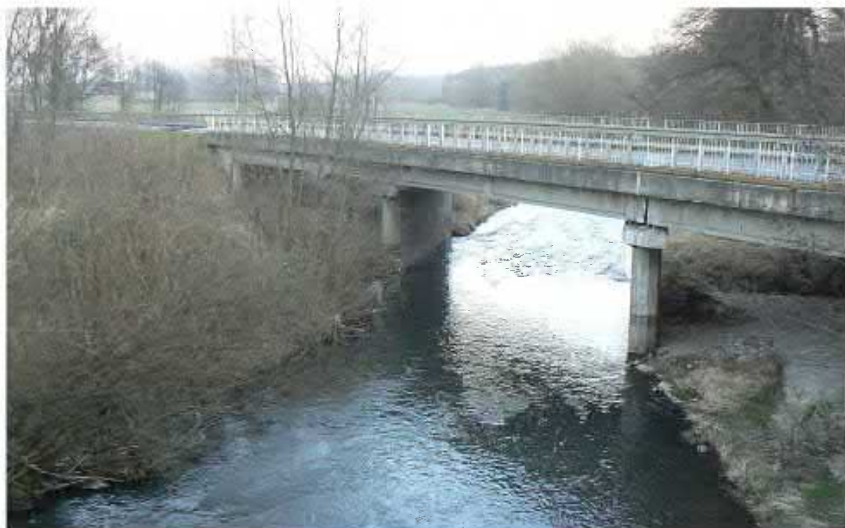
Foto. 59. Most drogowy - widok od strony stanowiska górnego
