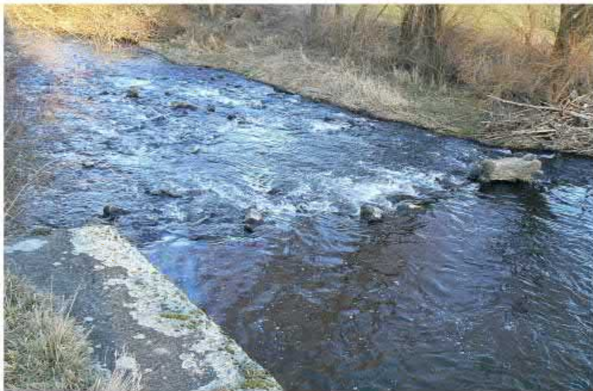
Foto. 54. stopień Wysocko - stanowisko dolne
