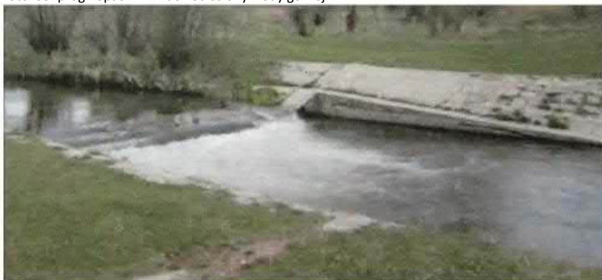
Foto. 56. próg Kopacz 1 - widok od strony wody dolnej
