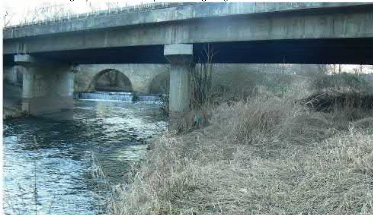
Foto. 60. Most drogowy - widok układu mostów- widok od strony wody dolnej
