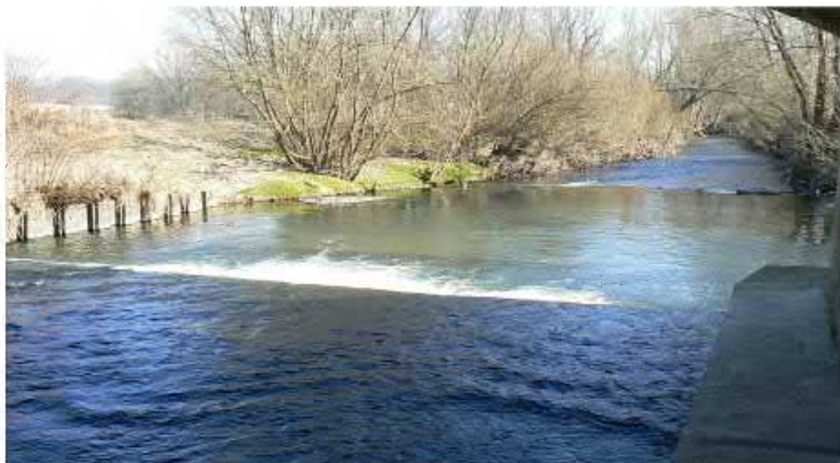
Foto. 67 Most DW 328 przy ul. Chojnowskiej - widok od strony wody górnej na nieckę wypadową
