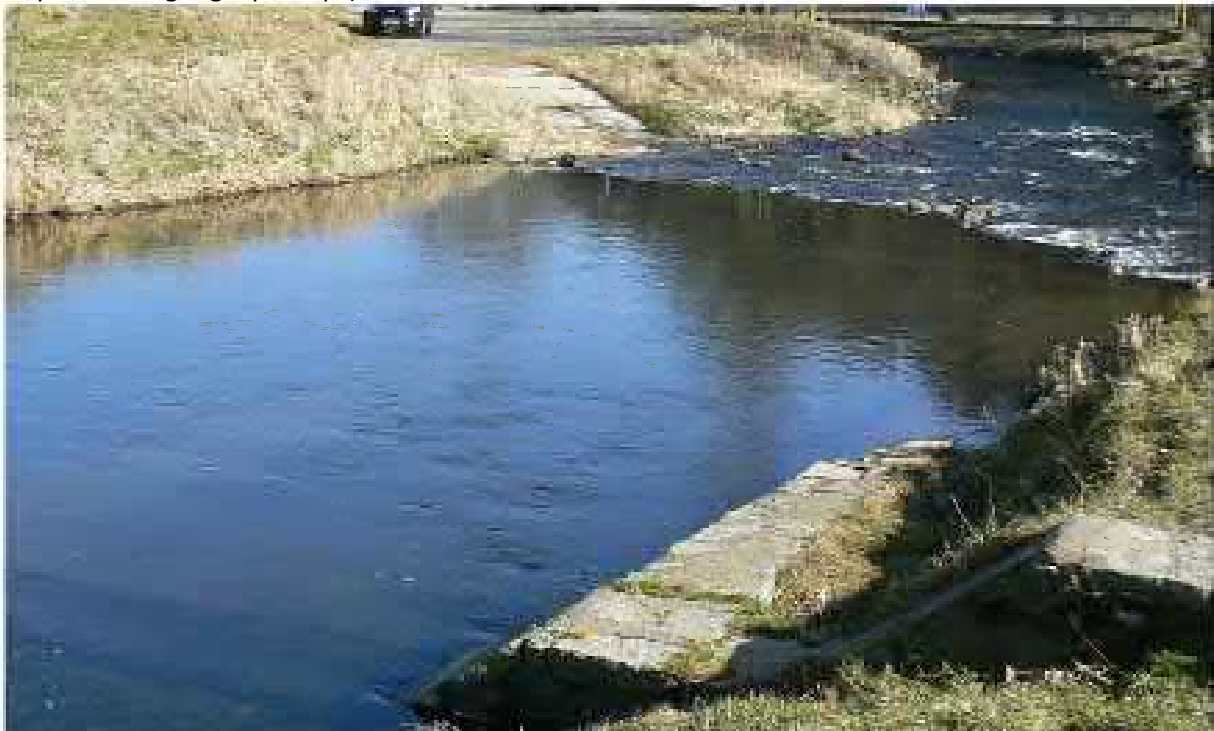
Foto. 77. Obiekt nr 30 - widok na bród od strony wody górnej
