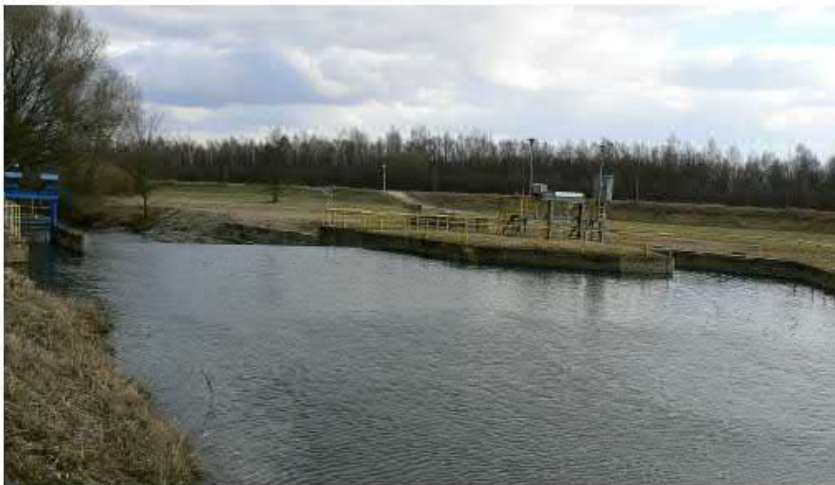
Foto. 43. Jaz Smokowice - wodociągi legnickie. Stanowisko górne jazu.
