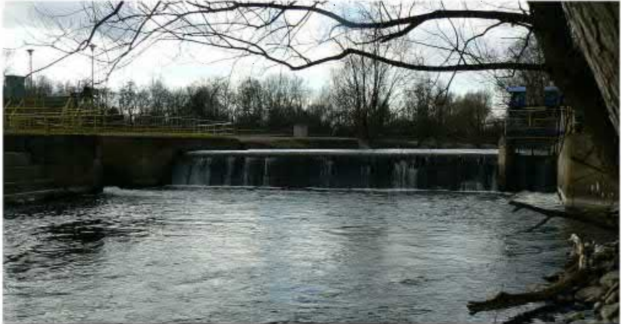
Foto. 41. Jaz Smokowice - wodociągi legnickie. Widok od strony wody dolnej.
