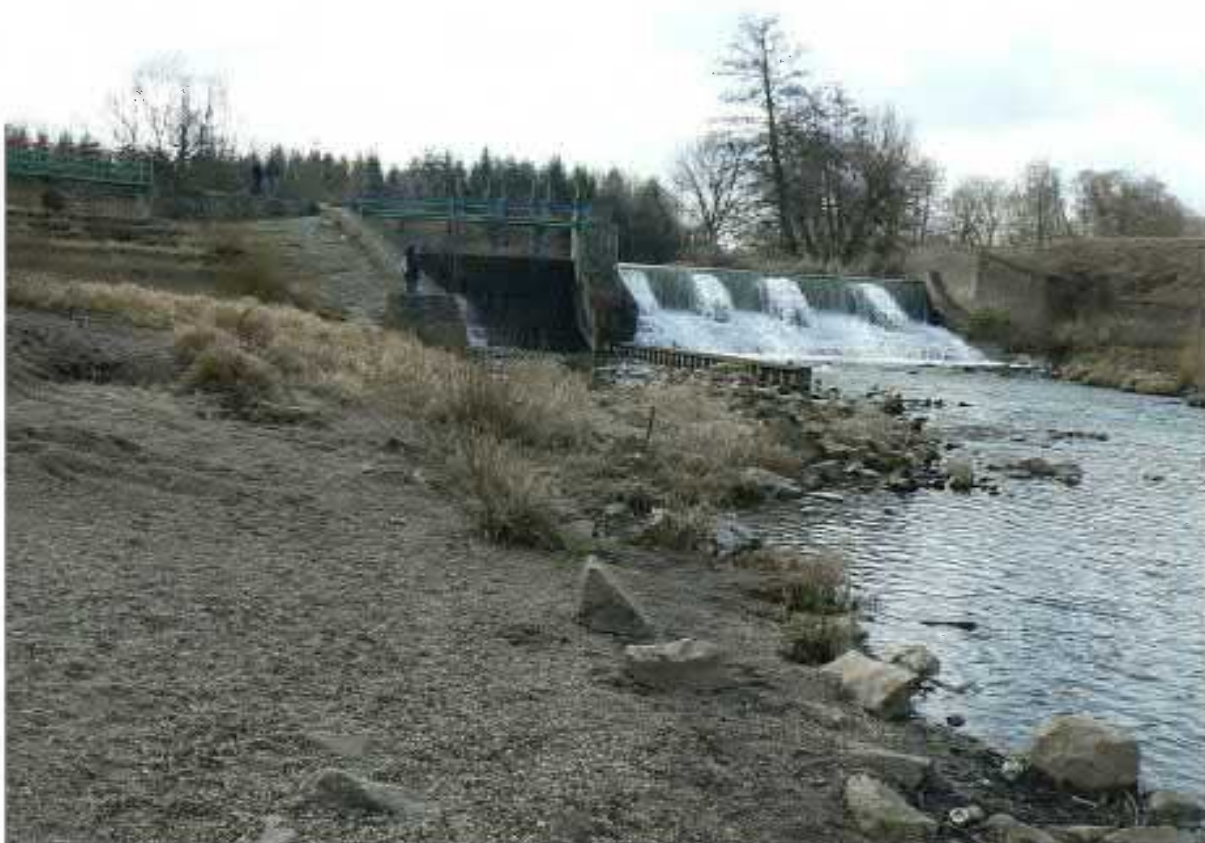
Foto.11. Widok od strony wody dolnej - stopień Prochowice.
