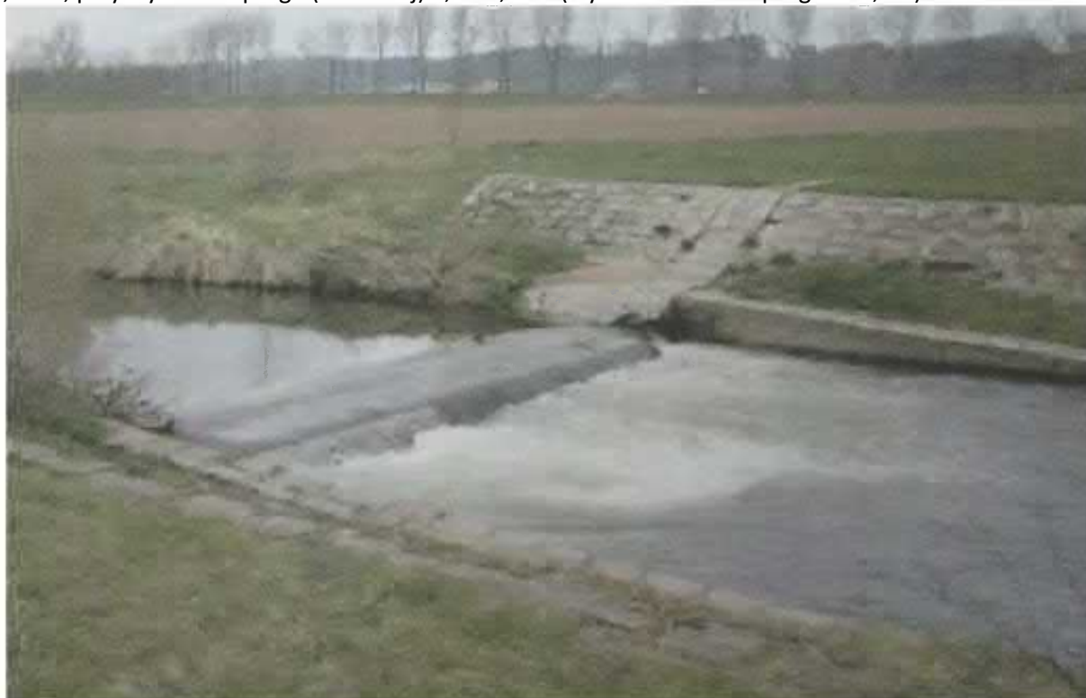
Foto. 57. próg Kopacz 2 - widok od strony wody dolnej
