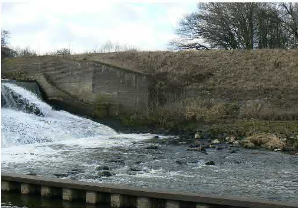
Foto.11. Widok jazu stałego i wału powodziowego od strony wody dolnej stopnia Prochowice
