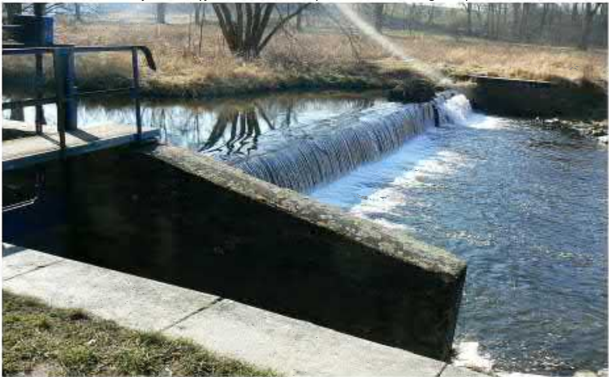
Foto. 82. Obiekt nr 32 - widok na ujęcie śluzy oraz próg korpusu jazu.
