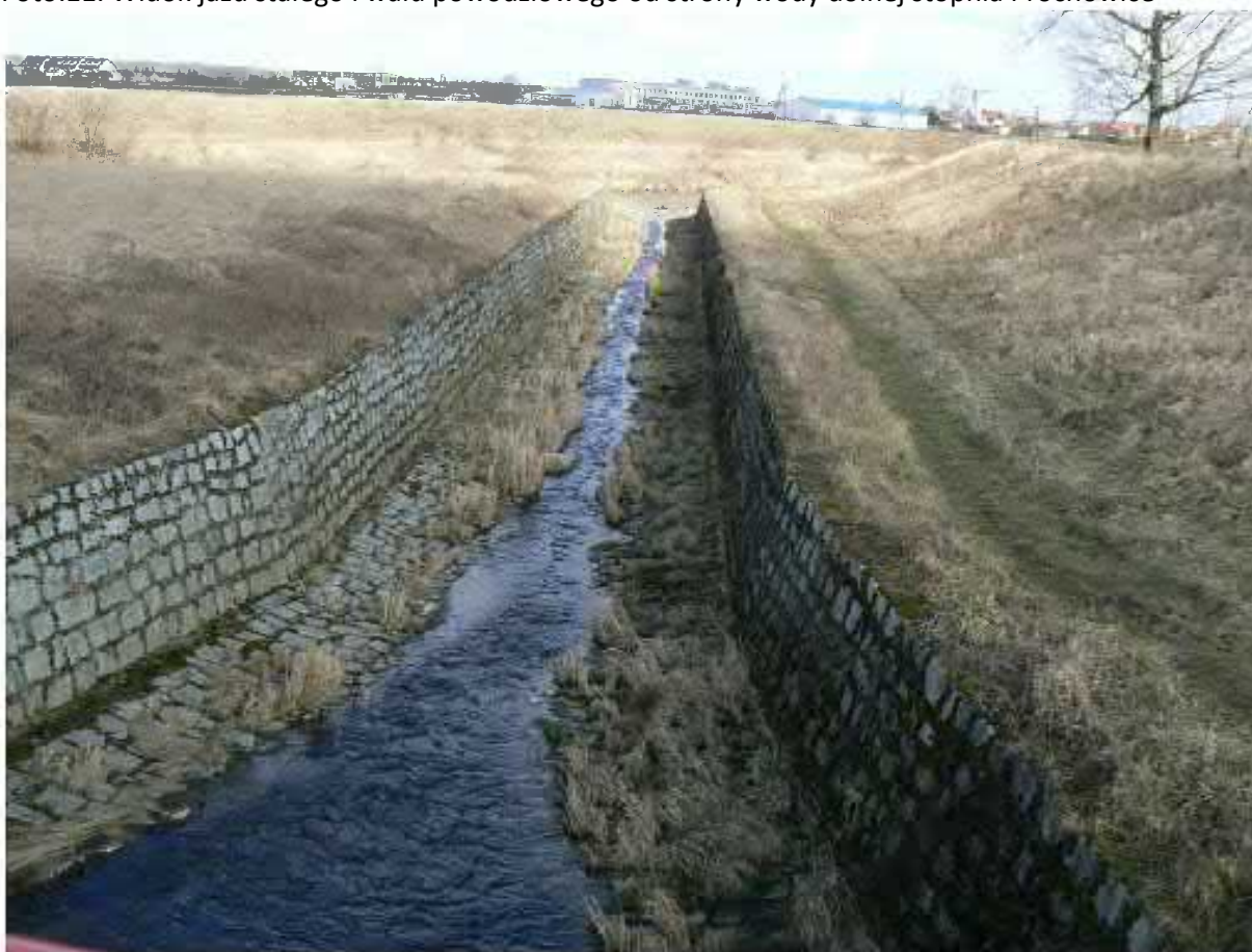
Foto. 12. Kanał płuczący stopnia Prochowice
