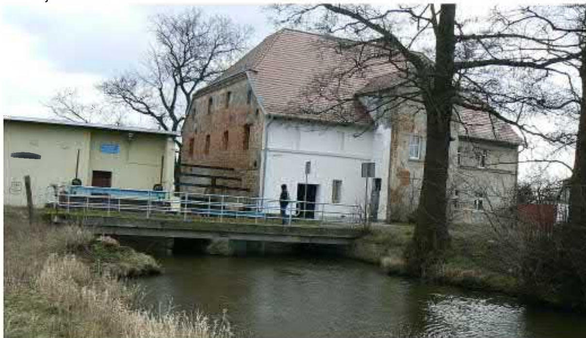
Foto 1. Budynek MEW 1 w Prochowicach
