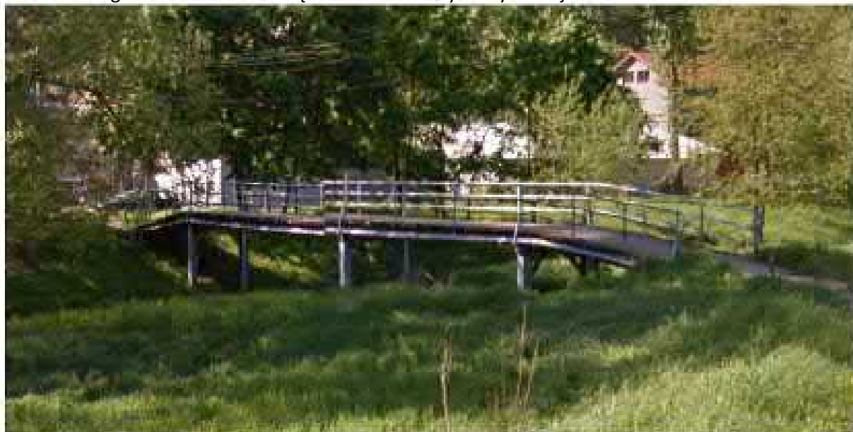
Foto. 69. Próg rzeczna wraz z kładką - widok.
