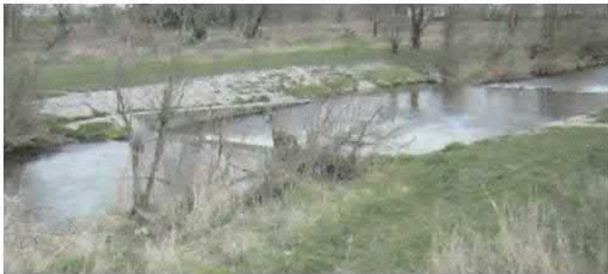
Foto. 55. próg Kopacz 1 - widok od strony wody górnej
