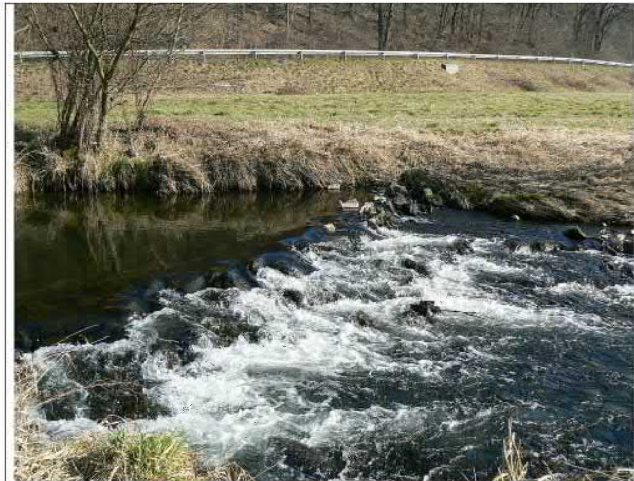
Foto. 80. Obiekt nr 31 -próg z kamieni
