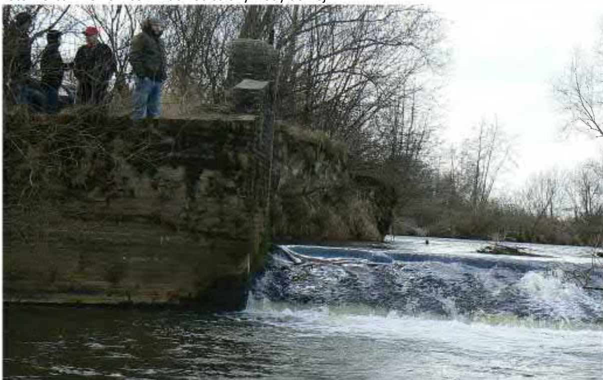
Foto. 13. Jaz Bieniowice - przyciótek. Widok od strony wody dolnej
