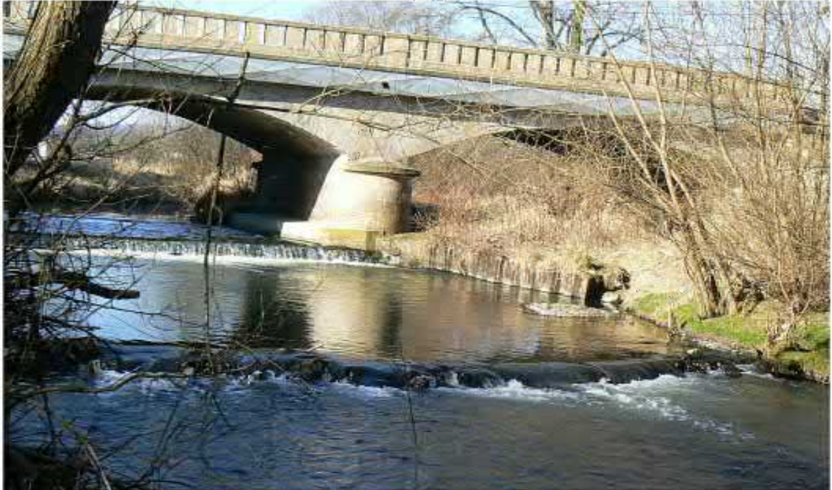
Foto. 65. Most DW 328 przy ul. Chojnowskiej - widok od strony wody dolnej
