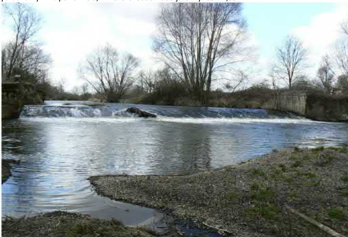
Foto. 13. Jaz Bieniowice - widok od strony wody dolnej
