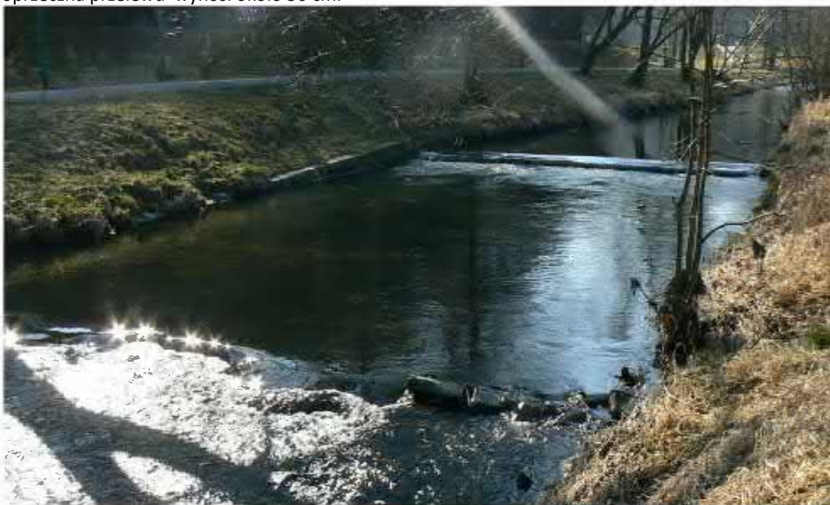
Foto. 73. Obiekt nr 29 - widok
