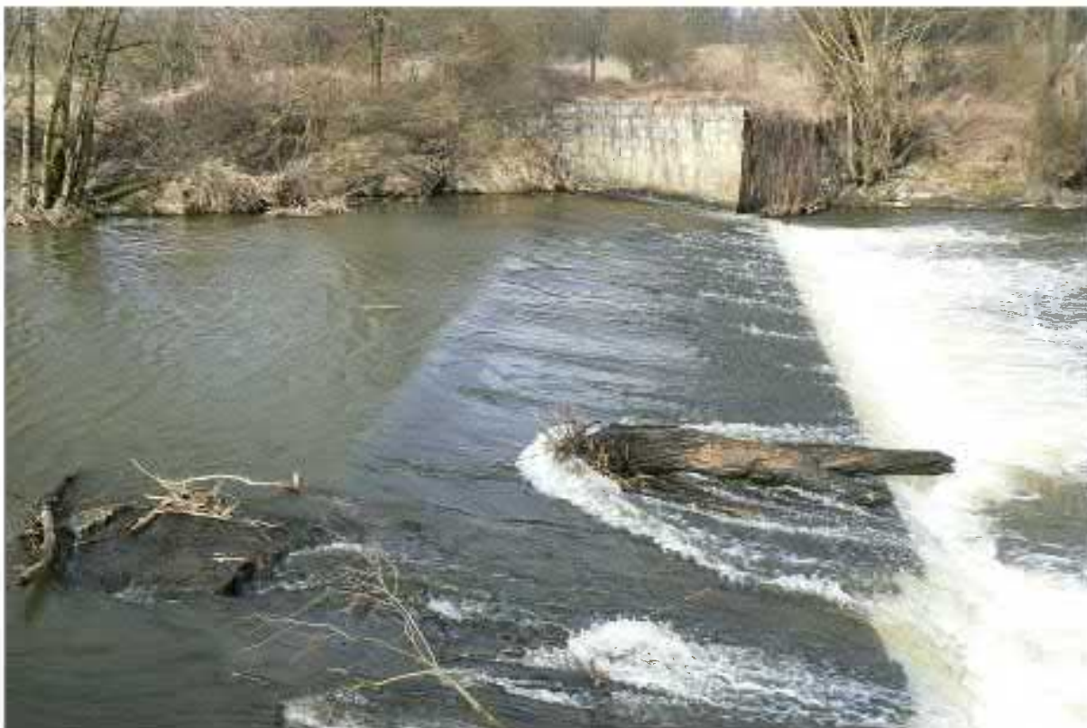
Foto. 14. Jaz Bieniowice - przelew. Widok od strony wody dolnej
