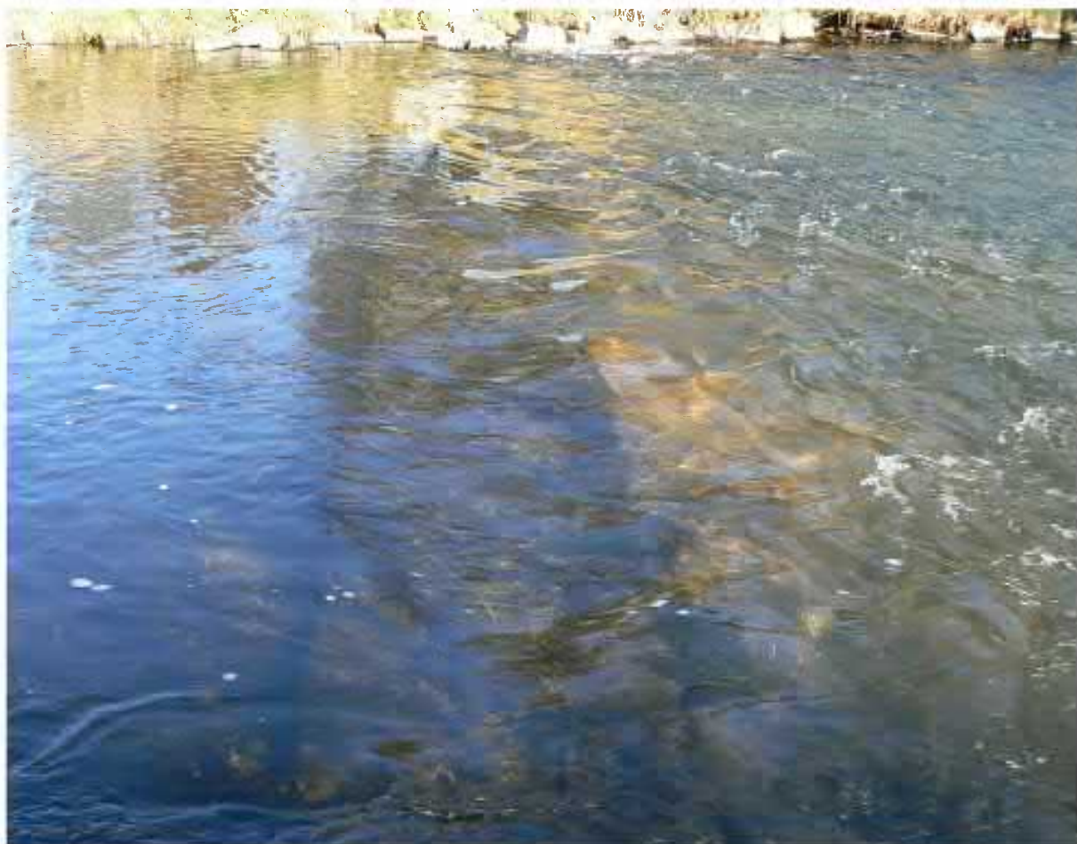
Foto. 72. Obiekt nr 27 - próg betonowy poniżej mostu DW 364
