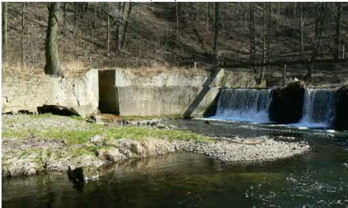
Foto. 90. Obiekt nr 34 przyczółek-
