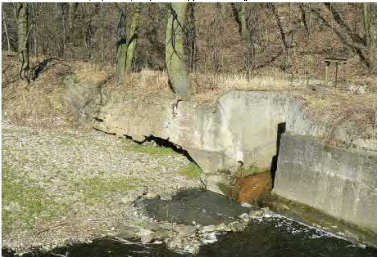
Foto. 92. Obiekt nr 34 przyczółek lewy
