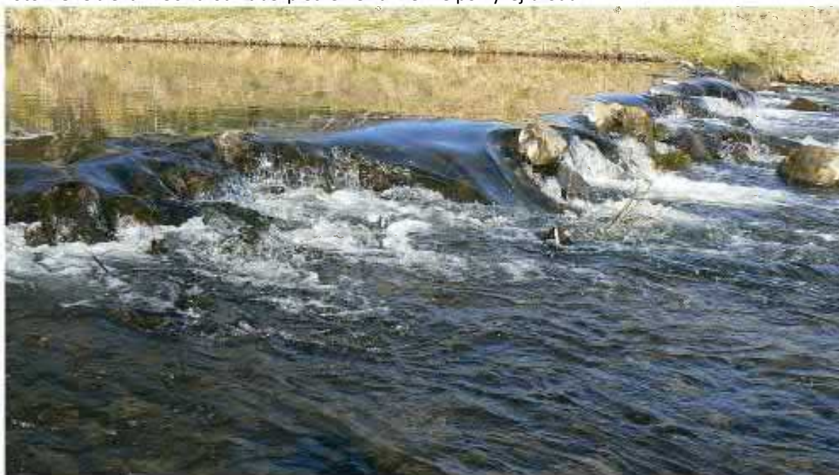
Foto. 79. Obiekt nr 30 - ubezpieczenie kamienne
