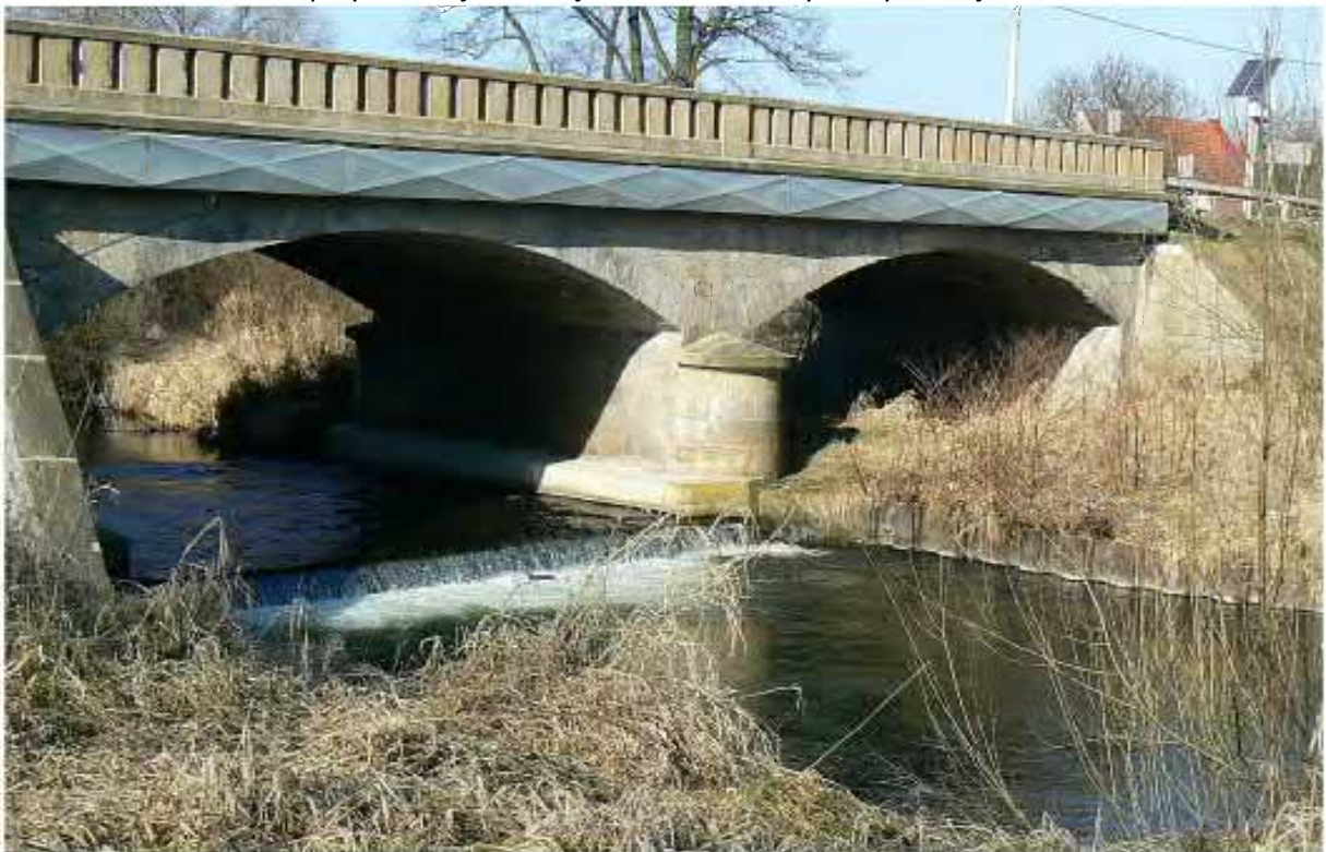
Foto. 66. Most DW 328 przy ul. Chojnowskiej - widok progu
