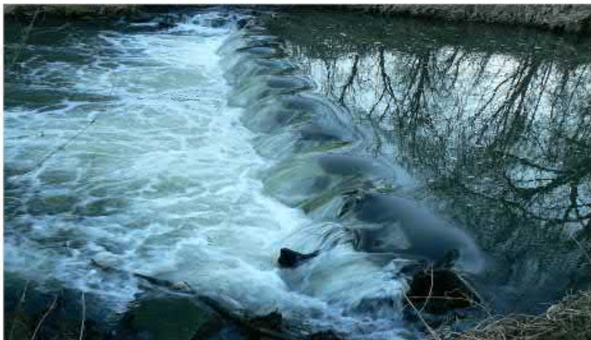
Foto. 58. próg w węźle złotoryjskim - widok od strony wody dolnej
