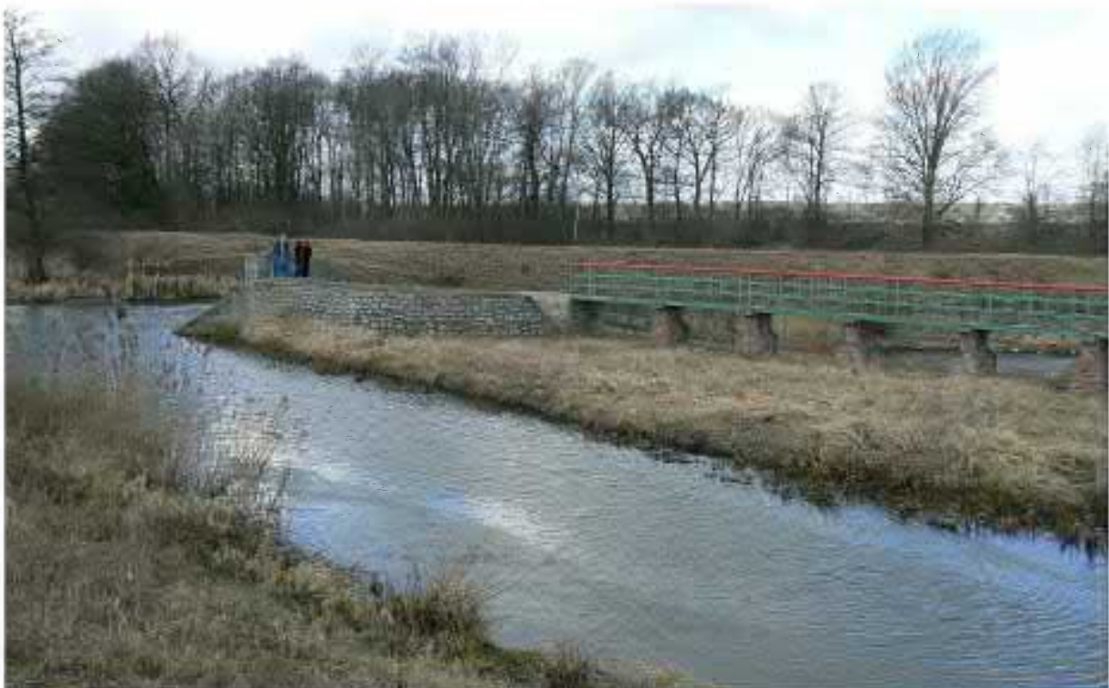
Foto.8. Widok na przelew powodziowy od strony wody górnej jaz Prochowice
