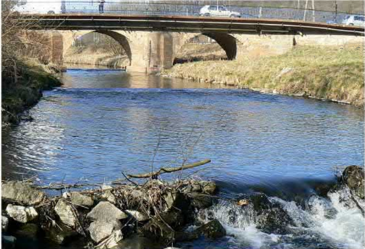
Foto. 70. Most drogowy DW 364 - widok
