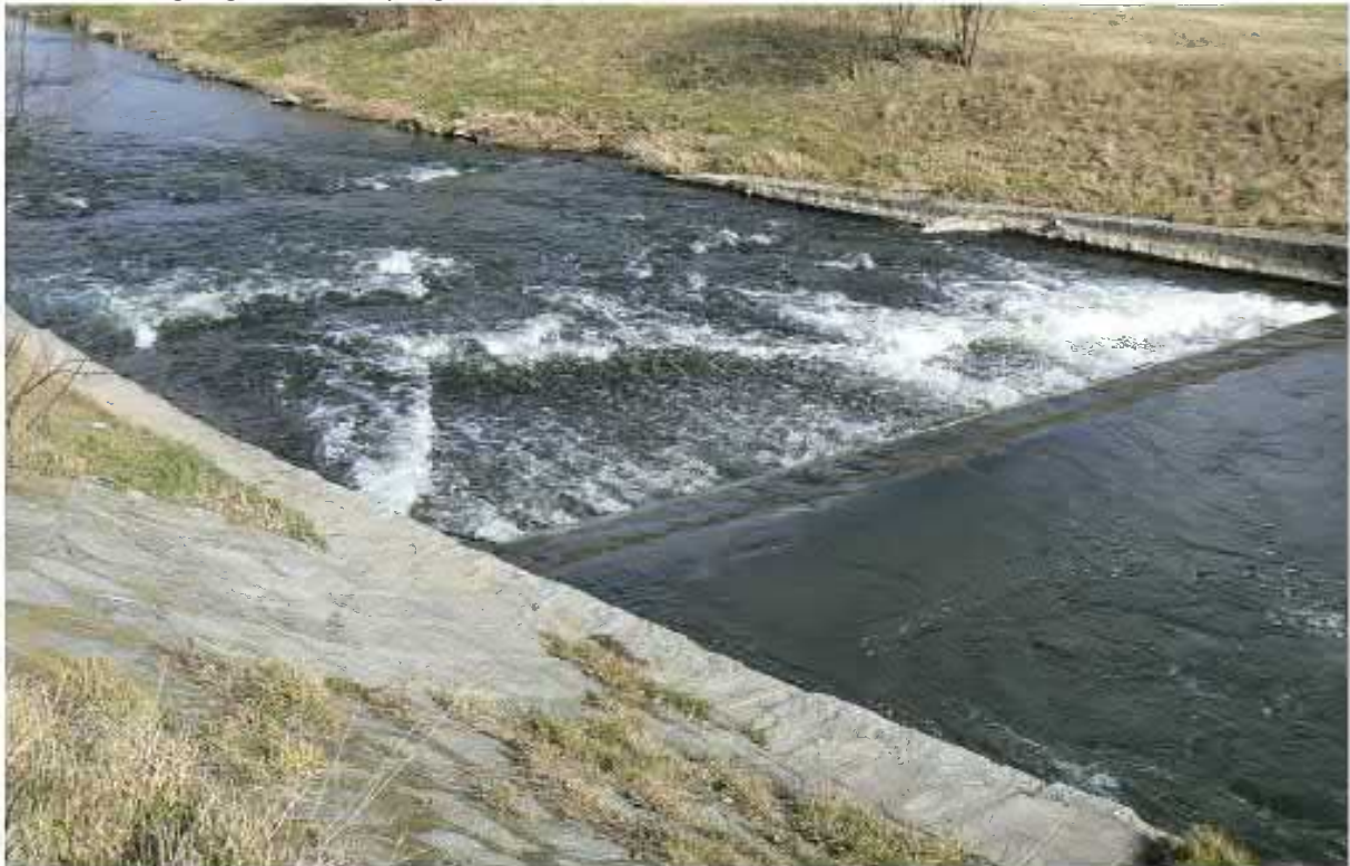
Foto. 20. Próg Legnica - PKP - widok stanowiska dolnego
