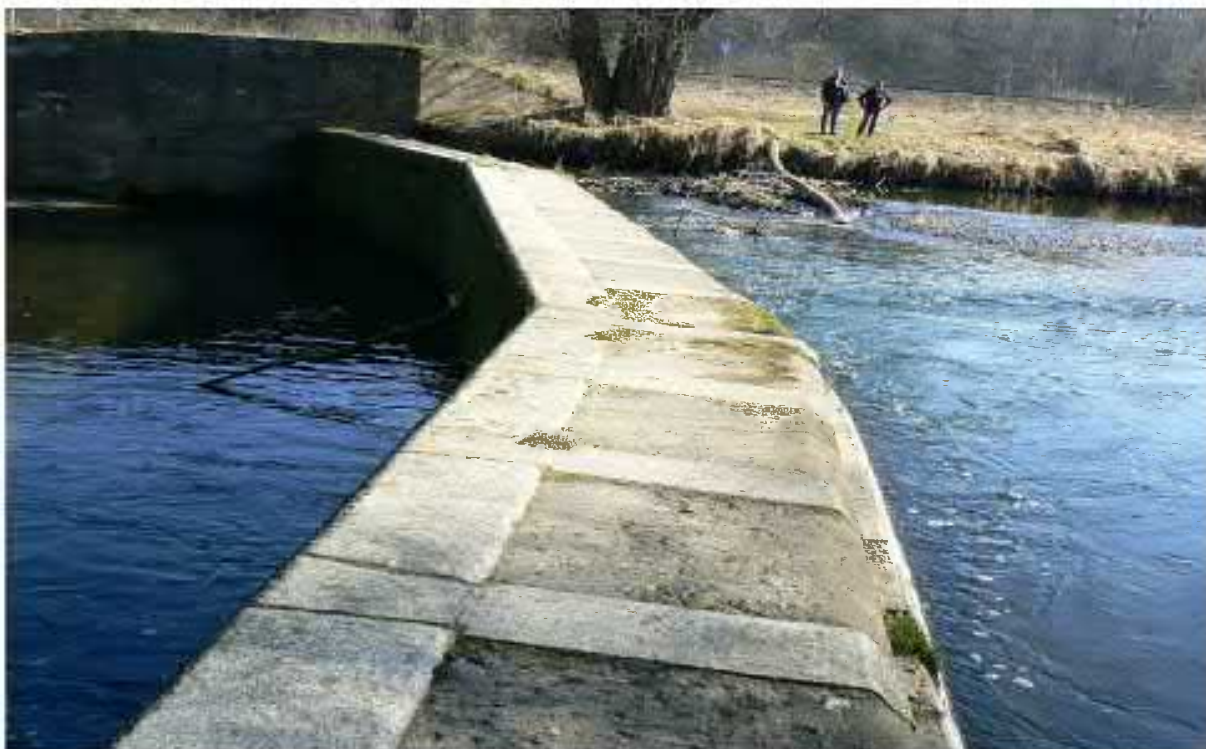
Foto. 84. Obiekt nr 33 - korpus przelewu jazu.
