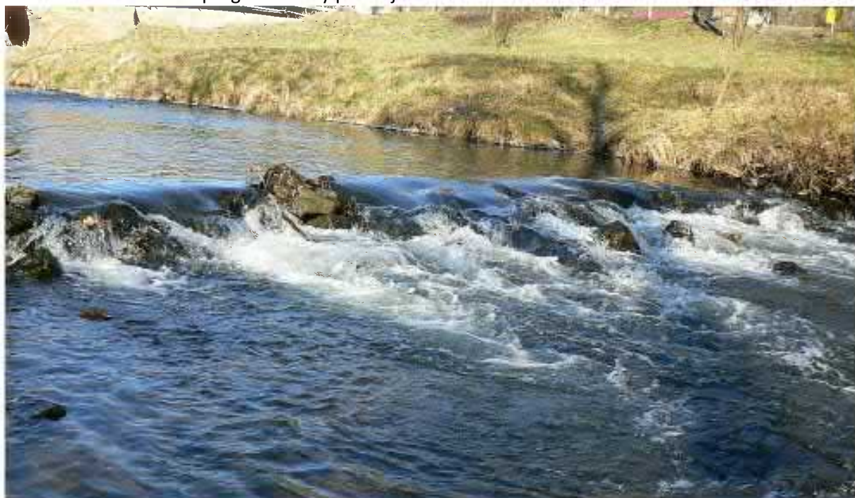
Foto. 73. Obiekt nr 27 -- próg kamienny poniżej mostu DW 364
