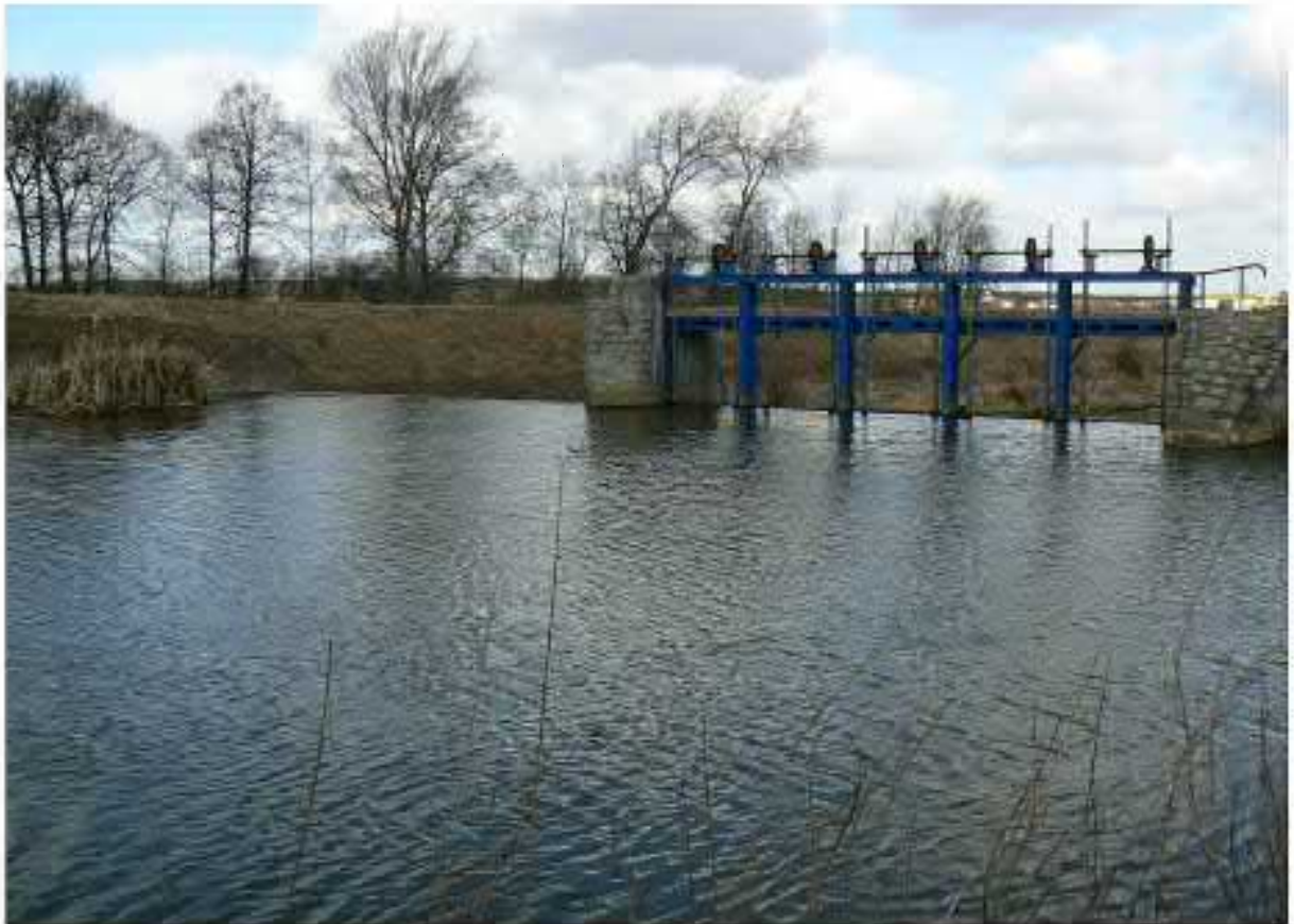
Foto.9. Widok na jaz stały i ruchomy od strony wody górnej stopnia Prochowice
