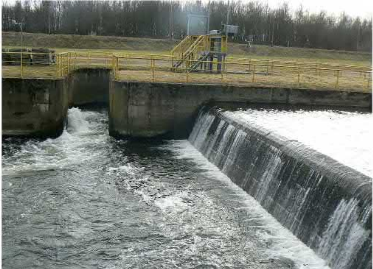
Foto. 42. Jaz Smokowice - wodociągi legnickie. próg.
