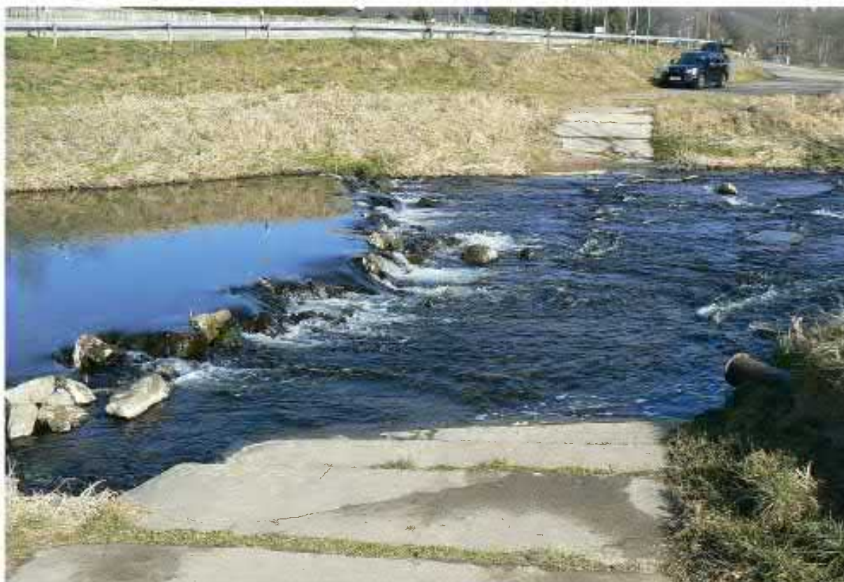
Foto. 78. Obiekt nr 30 -bród i ubezpieczenie kamienne powyżej brodu
