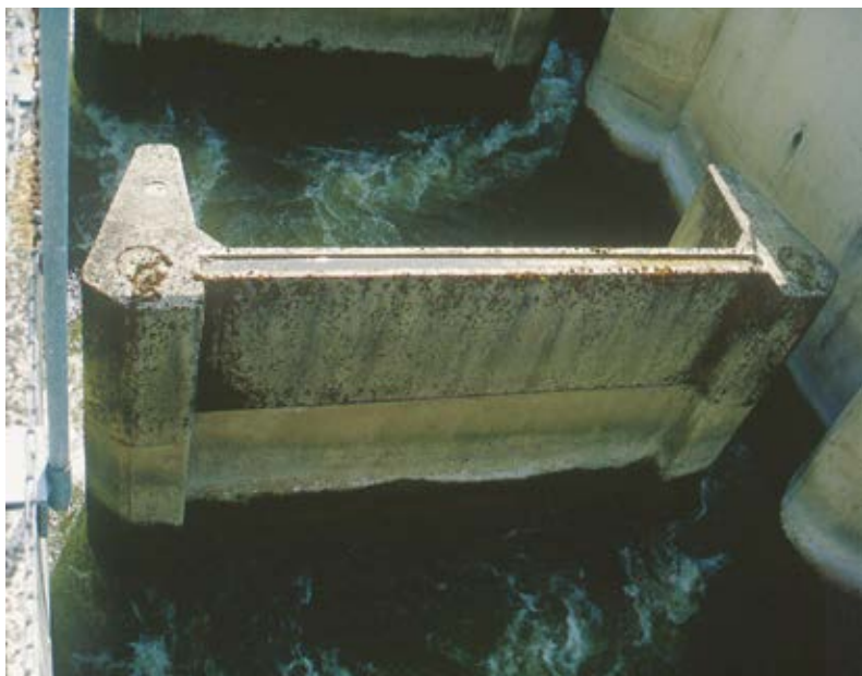
Ilustracja 5.14. Przeławka szczelinowa z dwiema szczelinami (schemat)
