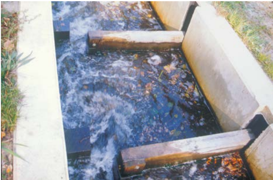
Ilustracja 5.20. Prąd wody w przełupce szczelinowej
