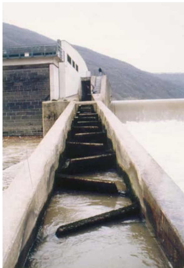
Ilustracja 5.7. Przykład przepławki romboidalnej. Jaz Lehmen na Mozeli. Widok od strony wody dolnej
