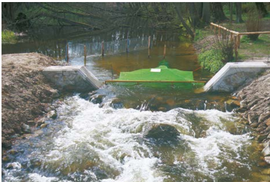
Ilustracja 6.1. Monitoring przepławki z wykorzystaniem narzędzia pułapkowego do połowu ryb, stosowany w celu monitorowania funkcjonowania przepławki rampy. Młyn Pritzhagen na rzece Stöbber (Brandenburgia)
