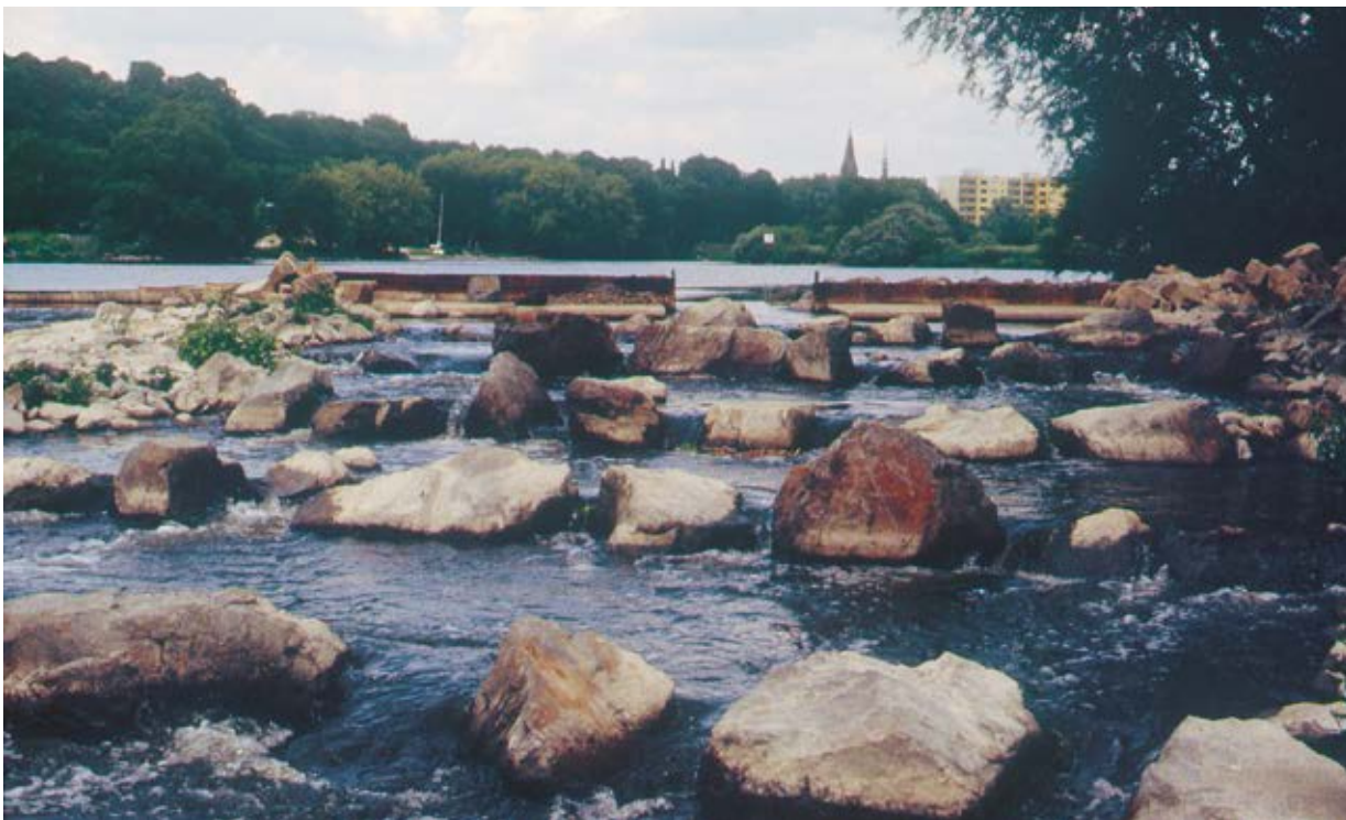
Ilustracja 4.41. Rampa dla ryb przy jazie Spillenburg. Zdjęcie po zakończeniu prac
