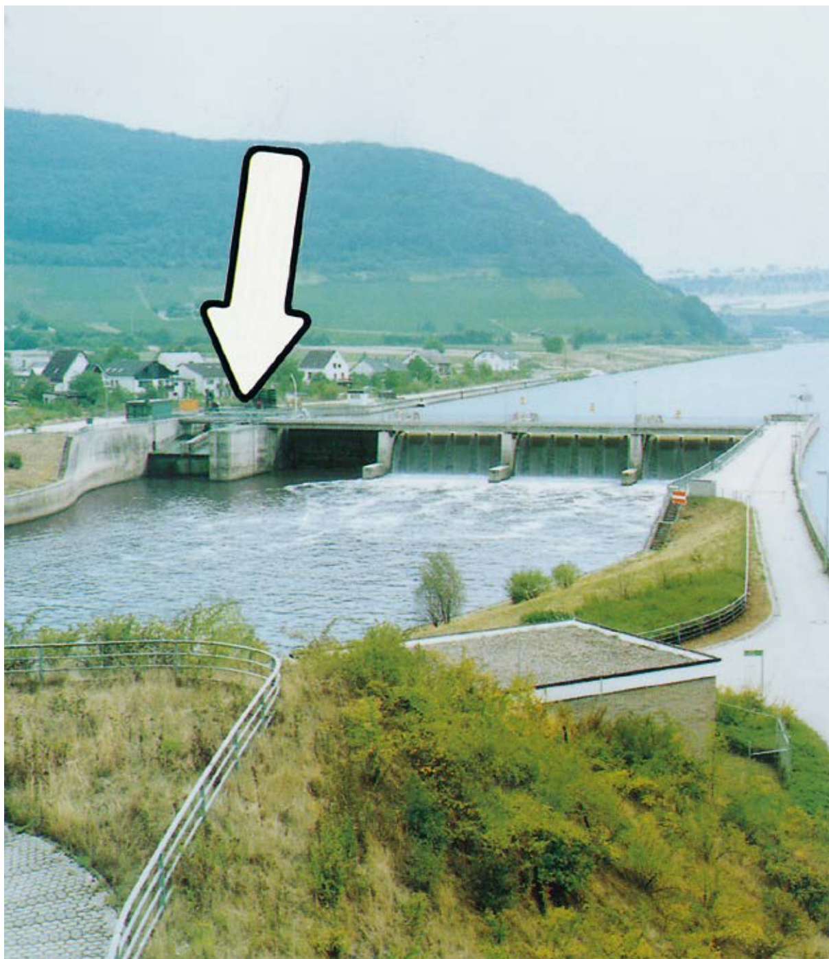
Ilustracja 5.44. Śluza dla ryb Schoden/Saar (widok od strony jaz). Śluza zainstalowana jest w filarze pomiędzy jazem i elektrownią (patrz: strzałka)
