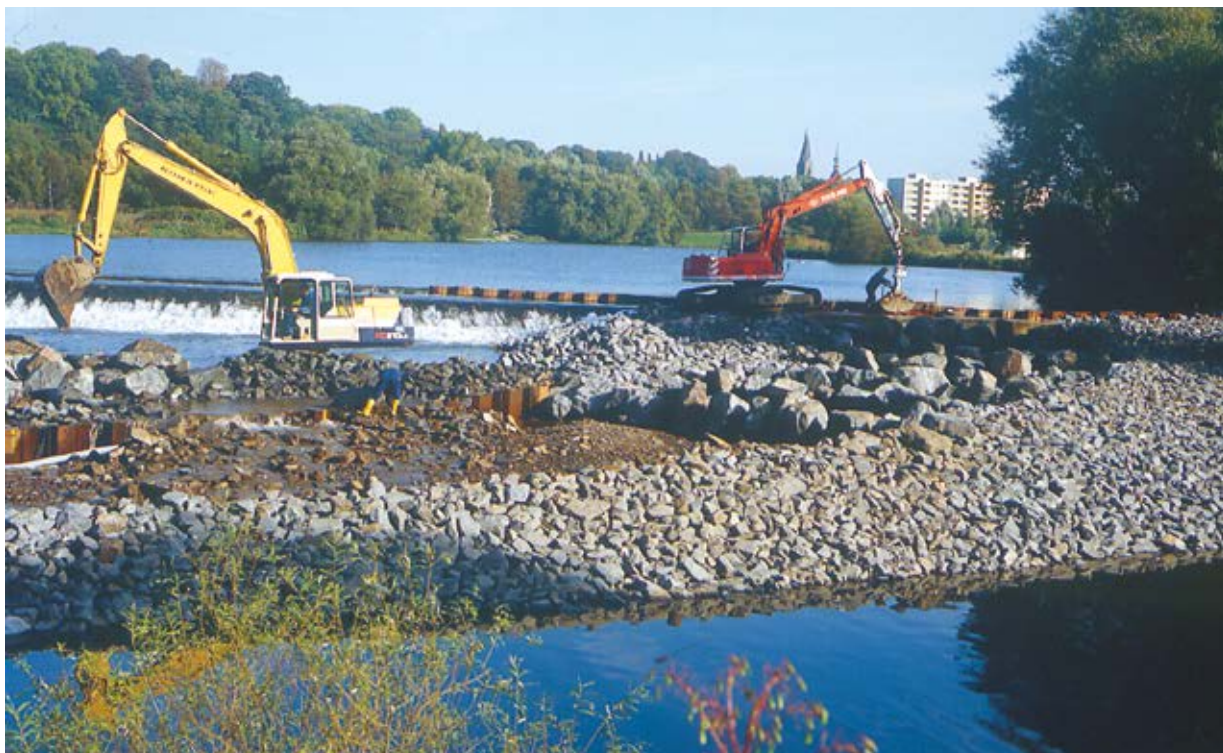
Ilustracja 4.40. Rampa dla ryb przy jazie Spillenburg. Zdjęcie z budowy
