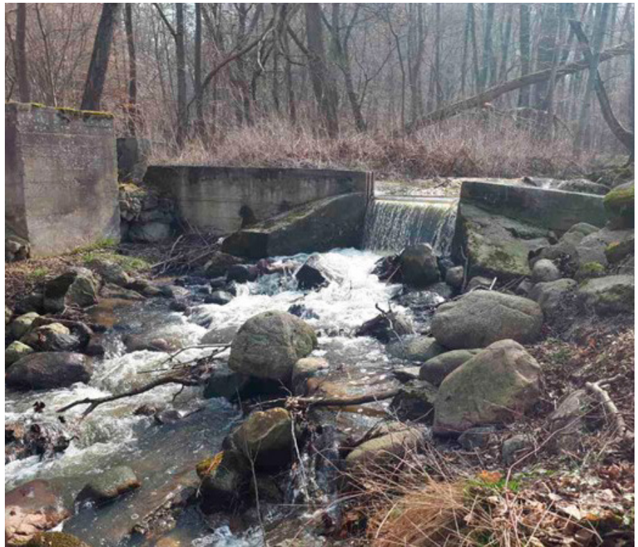
Fot. 5. Betonowy jaz na Stradance – uniemożliwia migrację w górę rzeki do rezerwatu Dolina Stradanki (fot. T. Brylski)
