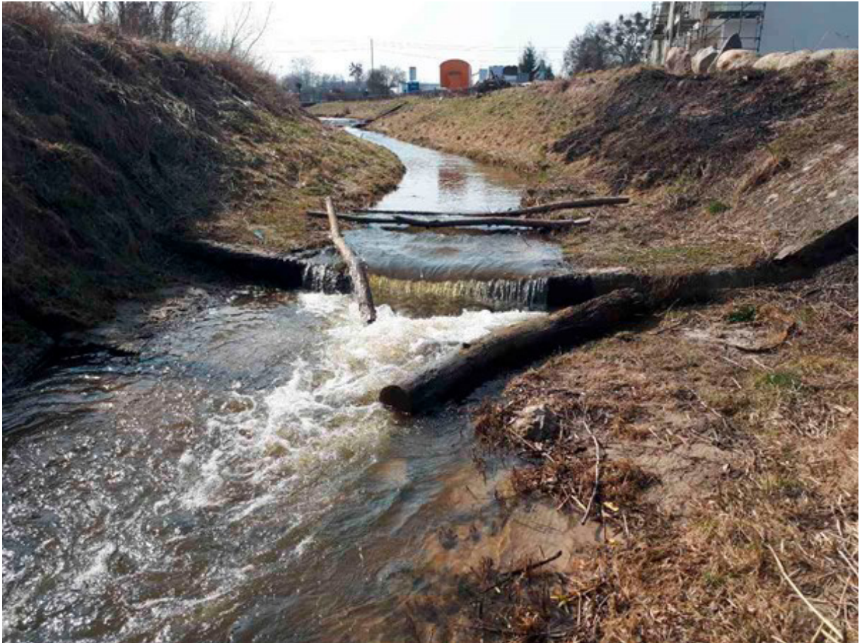
Fot. 4. Korekcja progowa na dolnej Stradance – seria 7 niskich progów betonowych, które utrudniają migrację ryb (fot. T. Brylski)
