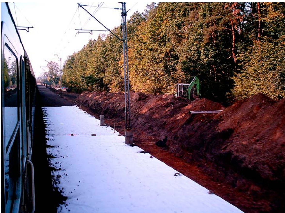
Remont linii kolejowej na linii Warszawa – Łódź 2006 (fot. W. Szymalski)
