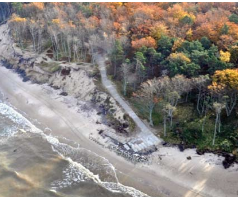
Ułatwiony dostęp dla pojazdów motorowych – wybetonowane zejście na plażę. Okolice Orzechowa/ Zapadłego, jesień 2010 r., fot. © WWF/ D. Bógdał
