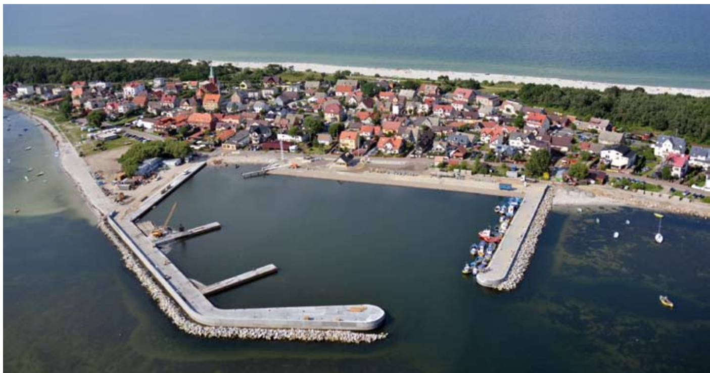
Fot. 4. Port w Kuźnicy, 2012 r., fot. © WWF/ D. Bógdał
