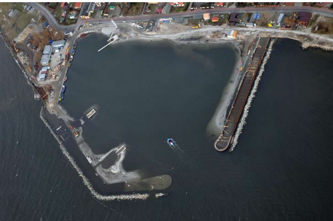
Budowa portu w Kuźnicy, styczeń 2012 r., fot. © WWF/ D. Bógdał
