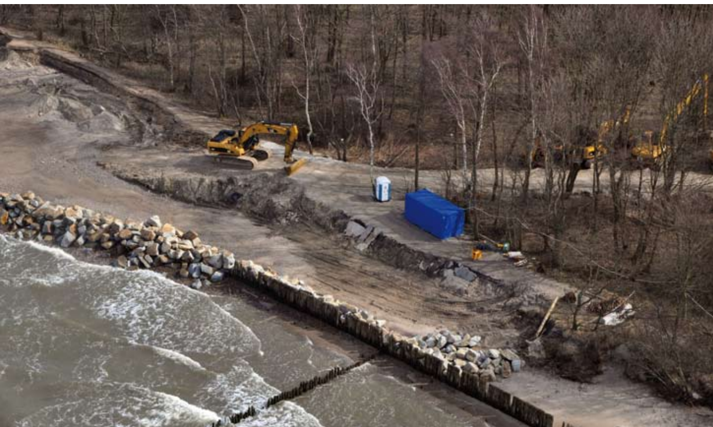
Budowa umocnień w Kołobrzegu, 2012 r., fot. © WWF/ D. Bógdał
