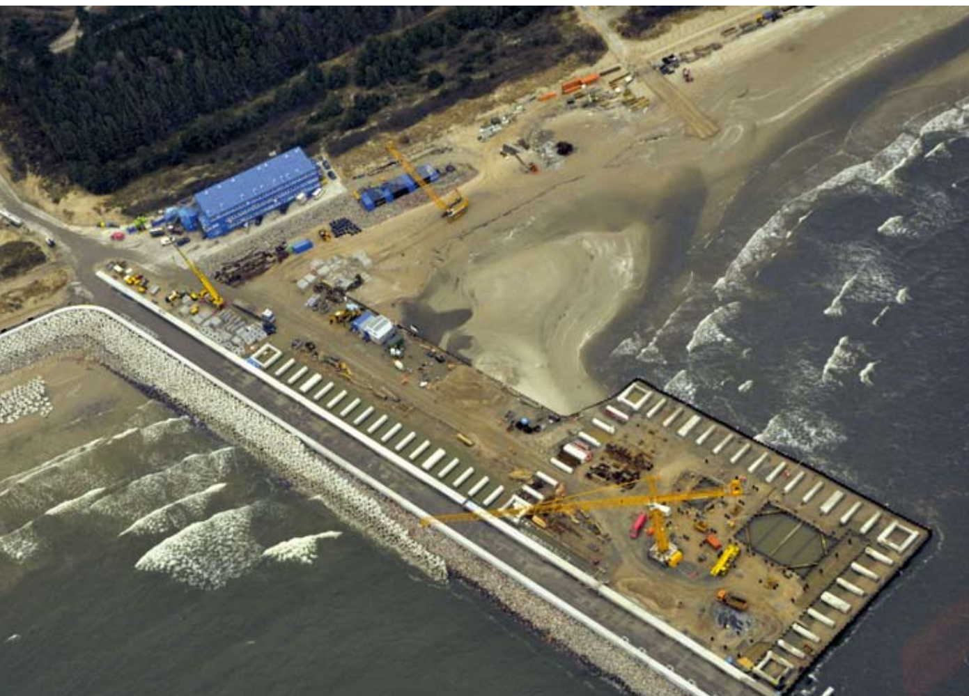
Budowa Gazoportu w Świnoujściu, styczeń 2012 r., fot. © WWF/ D. Bógdał
