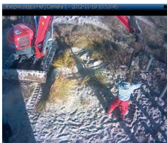
Fot. 8. Prace budowlane z wykorzystaniem ciężkiego sprzętu w 2012 roku
