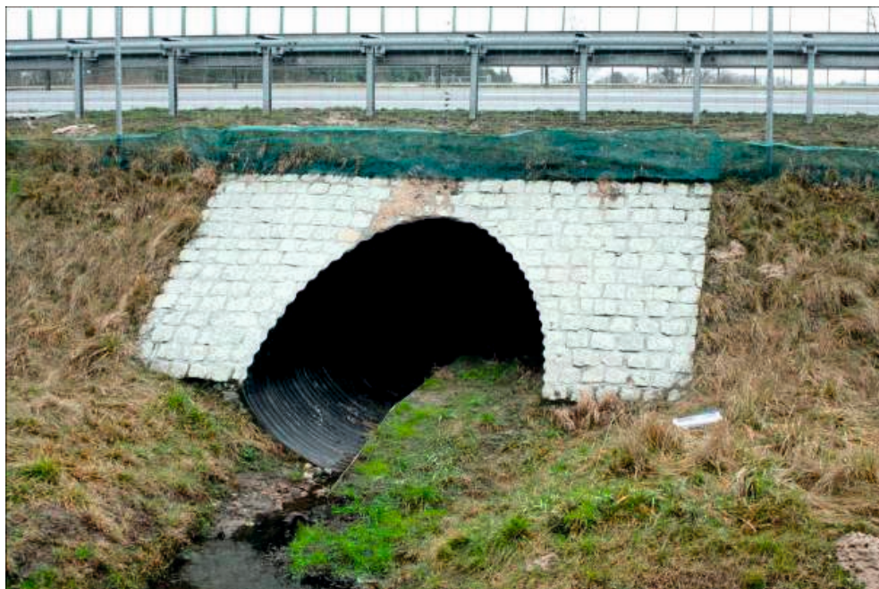
Fot. 2. Przepust pod autostradą A1. Wykorzystywany on jest jedynie przez małe ssaki (np. kuny, lisy)
