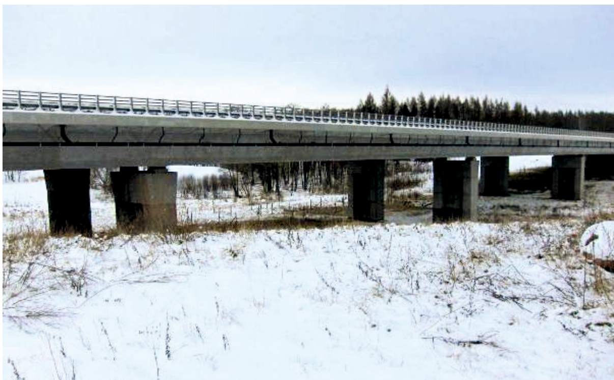
Fot. 3. Wiadukt drogowy nad rzeką Liską
